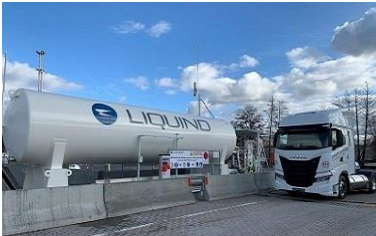
Снимка (© LIQUIND): Бензиностанция LIQUIND 24/7 за LNG в Щрулендорф в Горна Франкония
