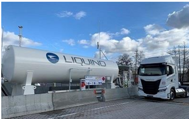
Foto (© LIQUIND): Čerpací stanice LNG společnosti LIQUIND 24/7 ve Strullendorfu
