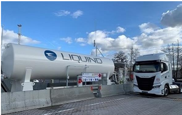
Photo (© LIQUIND): Station de ravitaillement en GNL LIQUIND à Strullendorf, Allemagne
