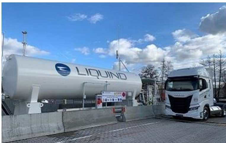
Foto (© LIQUIND): LNG-tankstation van LIQUIND 24/7 in de stad Strullendorf, in de Duitse deelstaat Opper-Franken
